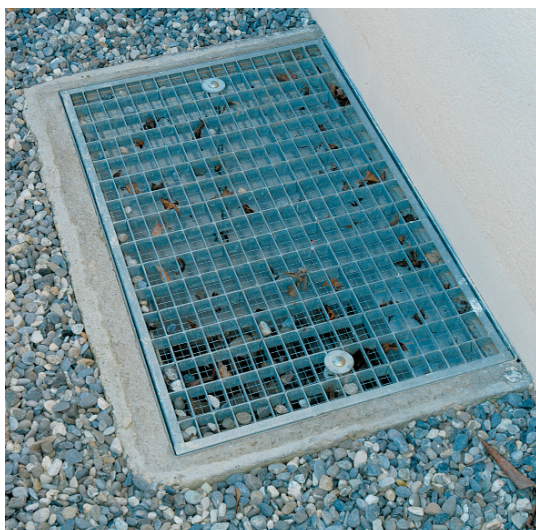
Sortie de secours munie d'un antivol
