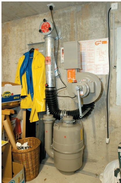
Appareil de ventilation dans un abri utilisé comme cave
