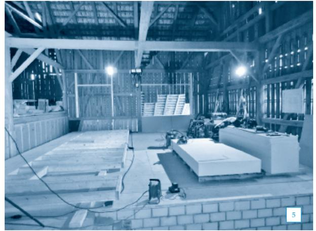
4 Die neue Holzkonstruktion steht direkt auf dem gemauerten Sockelgeschoss, dessen Bruchsteinmauerwerk teilweise verstärkt werden musste, um die neuen Räume zu tragen.
