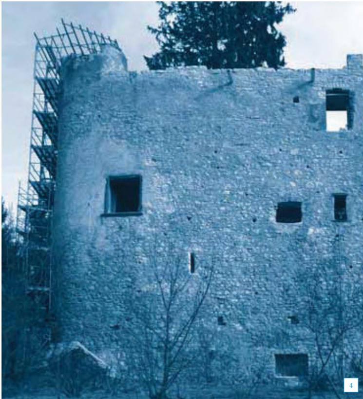
4 Vorbildliche Sanierung: Der Bewuchs ist entfernt, Risse sind geflickt, das Mauerwerk gefestigt, Wasserspeicher führen das Regenwasser von den Mauern weg. Dennoch bleiben die Details der über 700jährigen Baugeschichte dieser Fassade ablesbar (Arlesheim BL, Birseck).
