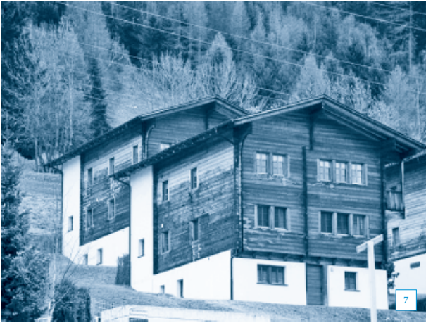
7 Zwei Häuser mit unterschiedlich verwitterten Fassaden. Foto: Berner Fachhochschule Architektur, Holz und Bau, Biel.
