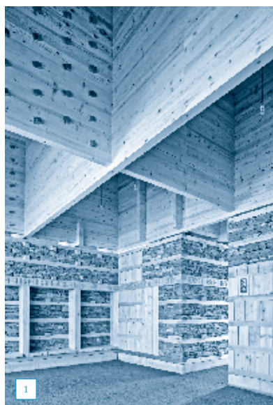
1 Bärenwaldhaus, Bern, 2012. Gold Prix Lignum 2012. Bauherrschaft: Tierpark Dählhölzli und Stadtbauten Bern. Architektur und Gesamtleitung: Architekturbüro Patrick Thurston, Bern. Holzbauingenieur: Indermühle Bauingenieure, Thun. Holzbau: Gfeller Holzbau GmbH, Worb. Foto: Ralph Hut, Zürich.
