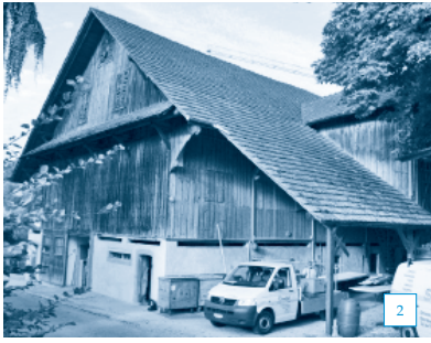
2 Die Scheune in Maschwanden (ZH).
