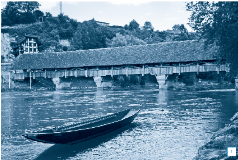
1 Kulturgut von nationaler Bedeutung: Die Neubrügg (1534/35 erbaut) ist die älteste erhaltene Holzbrücke im Kanton Bern. Sie darf seit 2010 nicht mehr mit Lastwagen befahren werden. Foto: Samuel Bauhofer, Fachbereich KGS.
