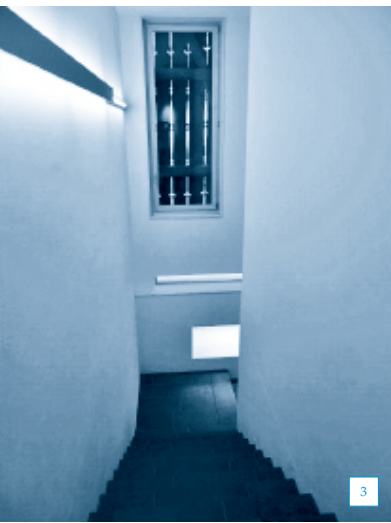
3 Treppenhaus mit Lichtschacht. Für die neuen Holzfenster verwendeten die Strebels hochwertiges Schweizer Fichtenholz. Fotos: Berner Fachhochschule Architektur, Holz und Bau, Biel.
