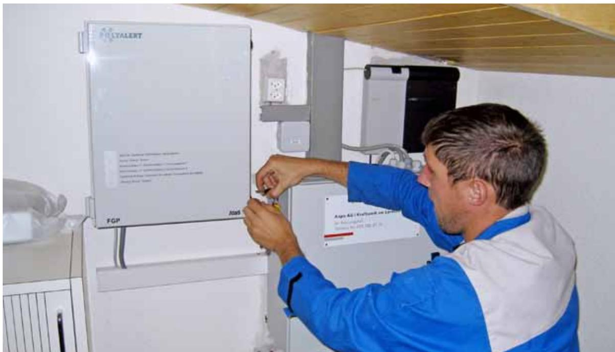
**Un installateur raccorde un nouvel appareil de télécommande POLYALERT. La qualité de la réception est suffisante sur ce site pour rendre inutile l'installation d'une antenne supplémentaire.**
