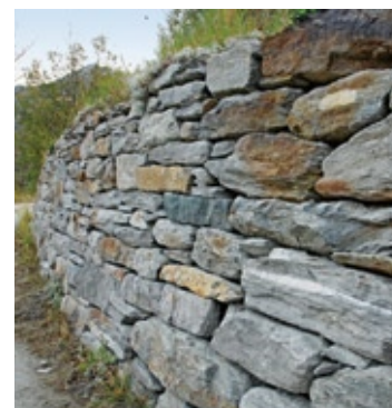
Fig. 82 Mur en pierres sèches
