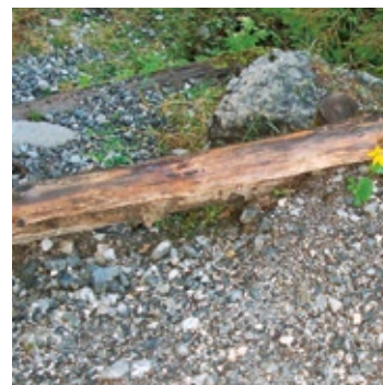
Fig. 88 Bordure détériorée
