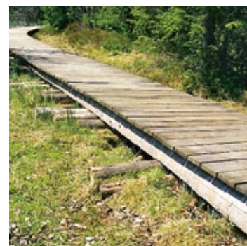
Fig. 53 Passerelle sur poutres transversales
