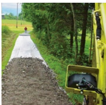
Fig. 20 La pose de la couche de fondation s'effectue frontalement.
