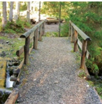
Fig. 43 Pont en bois
