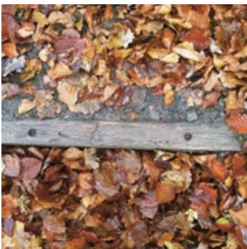
Fig. 56 Marche avec percements pour les fers d'armature
