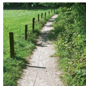
Fig. 14 Chemin avec couche de fondation
