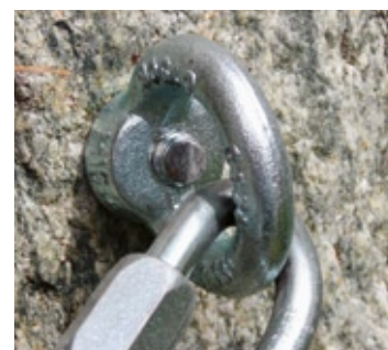
Fig. 65 Bon ancrage des chaînes
