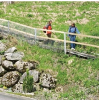
Fig. 62 Balustrade en bois
