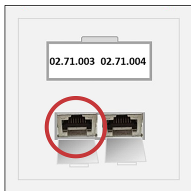
III. 47 : Connecteur avec sa numérotation spécifique. Dans cet exemple il s'agit du connecteur 3 dans le centre télématique.
